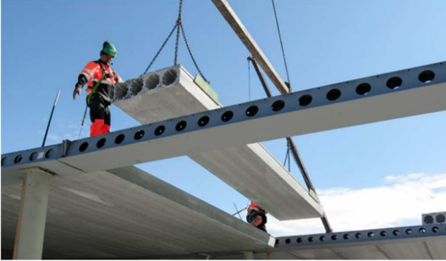
Pav. deltabeam sistemos perdanga
