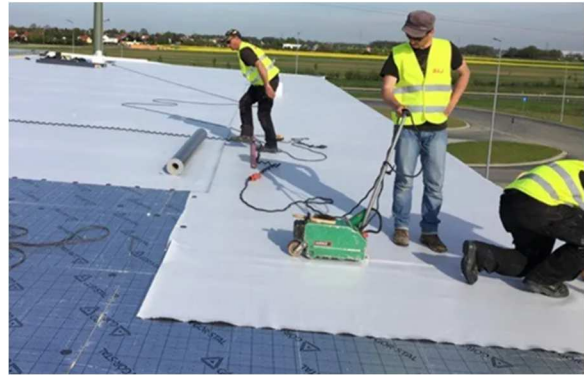
Pav. šiltinimas PIR ir dengimas FPO danga
