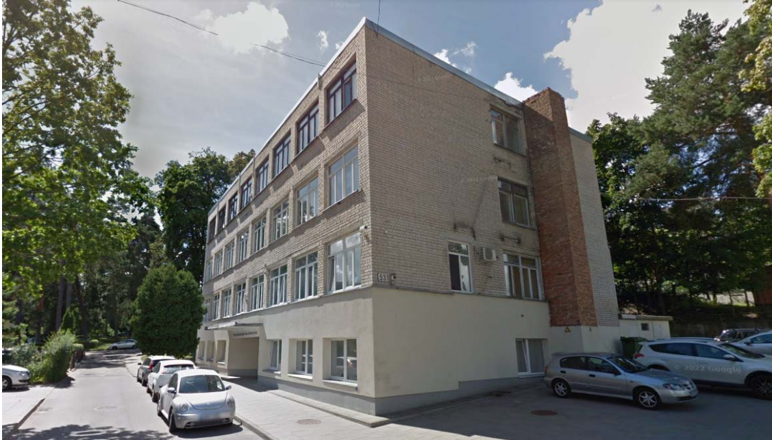
Rekonstruojamo pastato, Jeruzalės g. 53, Vilniuje, vaizdas iš šiaurės rytų pusės
