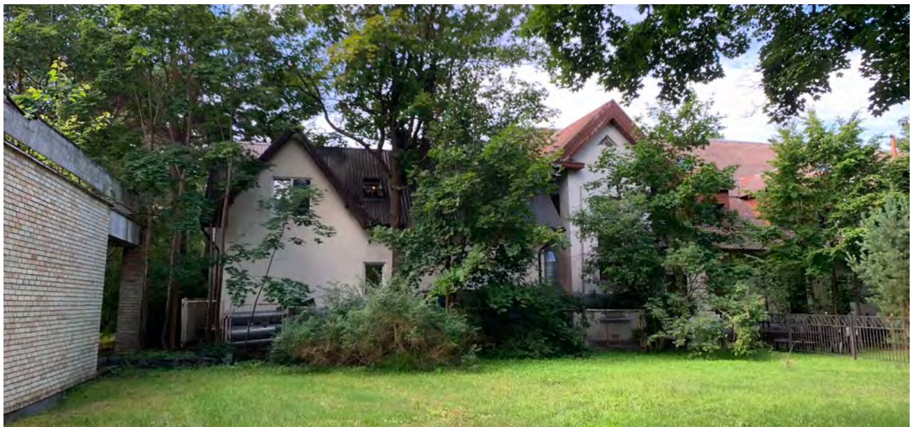
"Vandenis". Šiaurinis fasadas. Birutės al. 47
