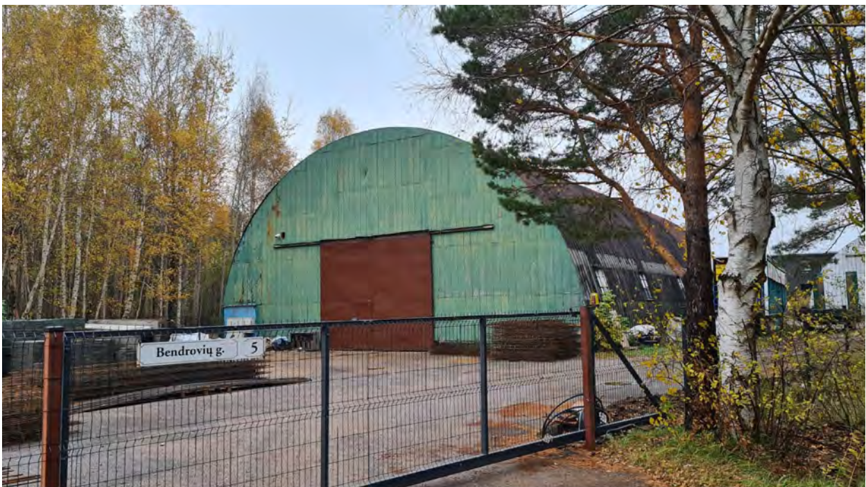
Pramonės ir sandėliavimo objektų teritorijos sklypas adresu Bendrovių g.5
