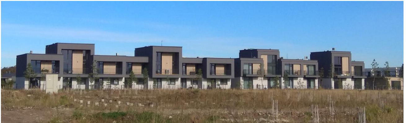
Gyvenamųjų namų kompleksas „Mano jūra“: pastatai 2 aukštų, sutapdintais stogais. Fasadų apdailai naudojamas šviesus ir tamsus tinkas.
