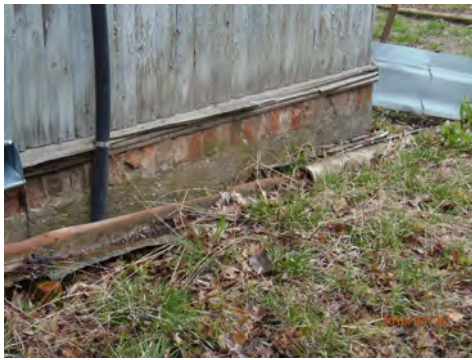
9 pav. Betono pamatas su raudonų plytų cokoliu
