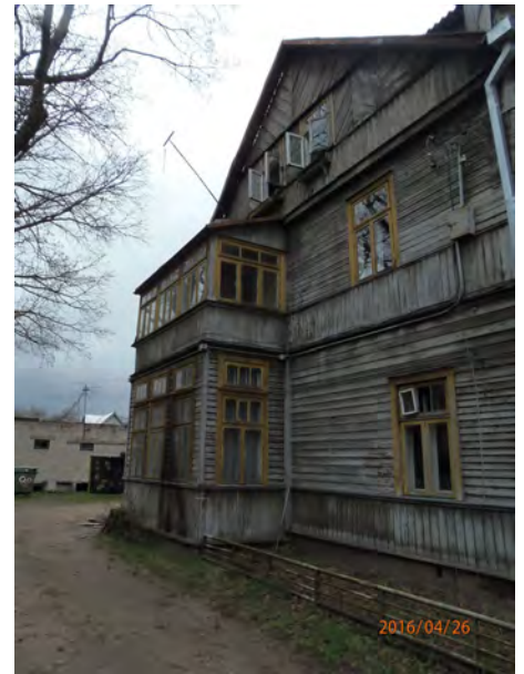
5 pav. Šoninis rizalitas pietiniame fasade
