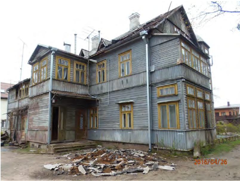
4 pav. Centrinis rizalitas vakariniame fasade
