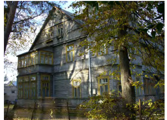
8 pav. Trikampės formos Š ir P fasadų skydų apkalimo medinėmis lentelėmis tipas
