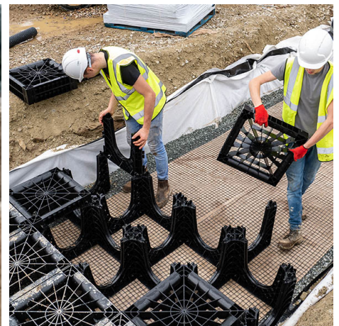
Šaknų apsauginė / irigacinė sistema BLUEGREEN URBAN „RootSpace“
